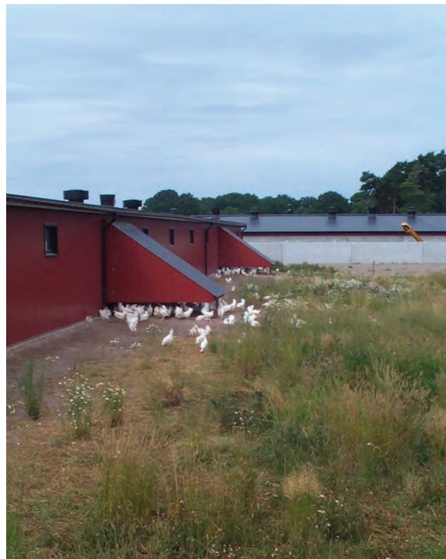
Overbygd inn- og utgang bidrar til å unngå trekk i hønsehuset. Foto: Lise Grøva
