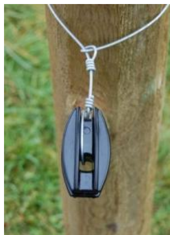
Figur 3. Ved skarpe retningsendring på gjerdet skal det benyttes spesialisolator (Foto: DeLaval/ Jan Pettersson).
